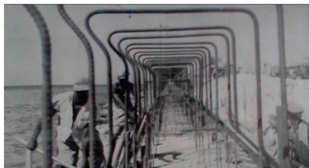
Imagen 15: Encabillaje del muro de contención del malecón. Fuente: MOP. Boletín oficial. Plan de Obras del Presidente Batista.
